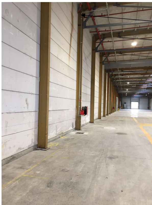
Figure 3-3 : Hall 1 – Portique et mur coupe-feu séparatif avec le hall 2.
